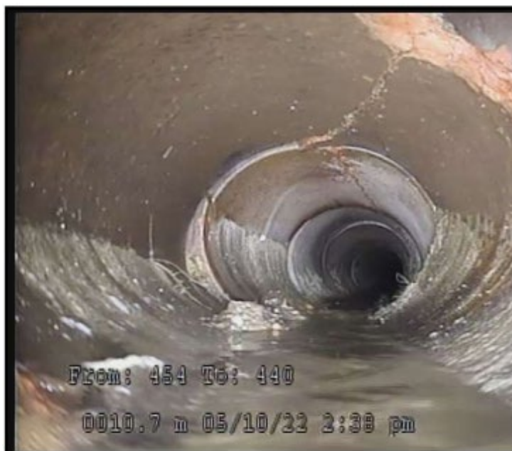
10.7 Crack Longitudinal Hinge, 3
